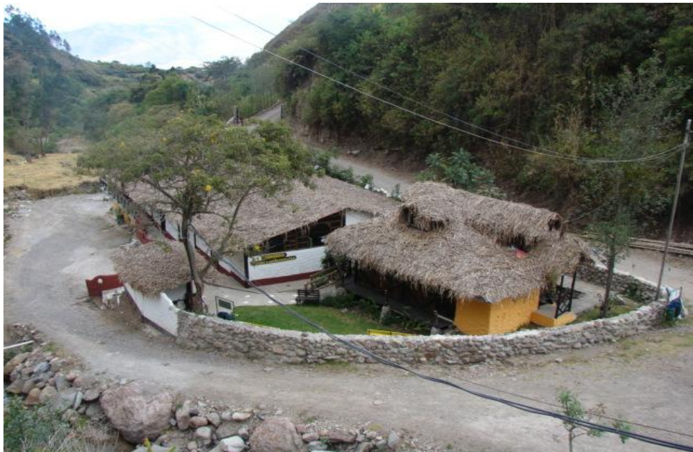
Fotografía 11: SALÓN DE CONVENCIONES
