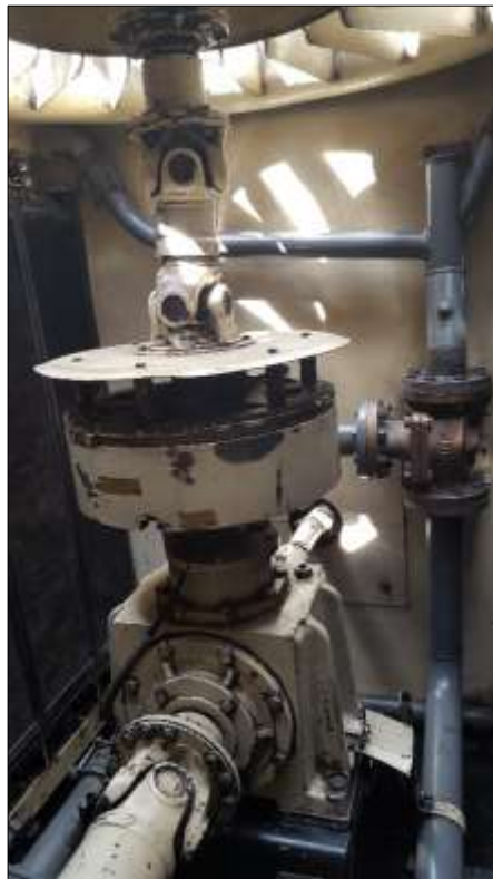
Ventilador con acoplador electromagnético
