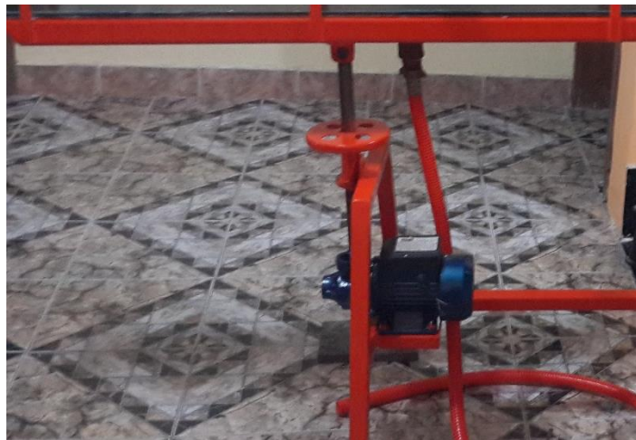
Fotografía 10. Instalación de la bomba
