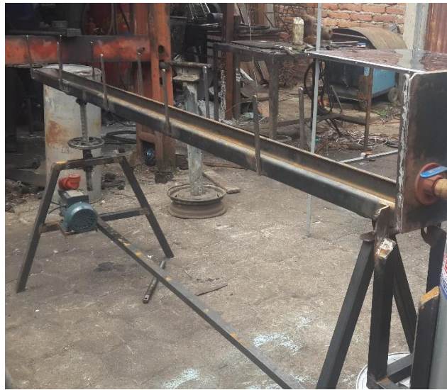
Fotografía 3. Estructura metálica del equipo
