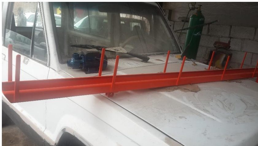
Fotografía 6. Pintura de la estructura metálica
