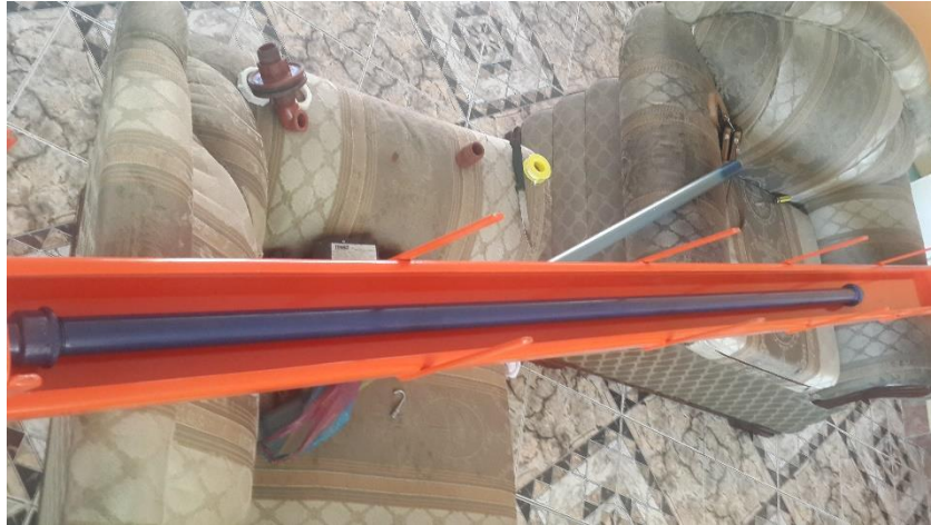
Fotografía 7. Instalación del sistema de agua
