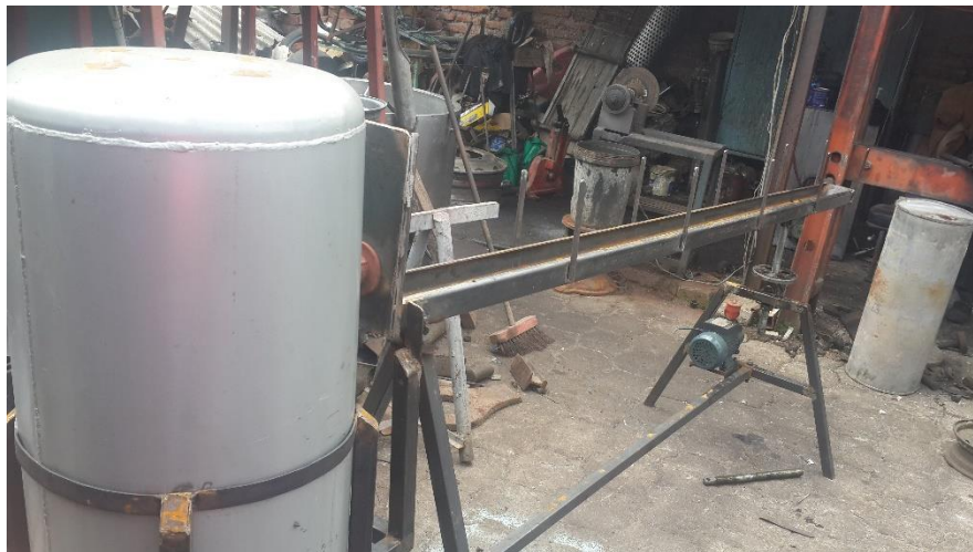
Fotografía 4. Estructura metálica y tanque principal
