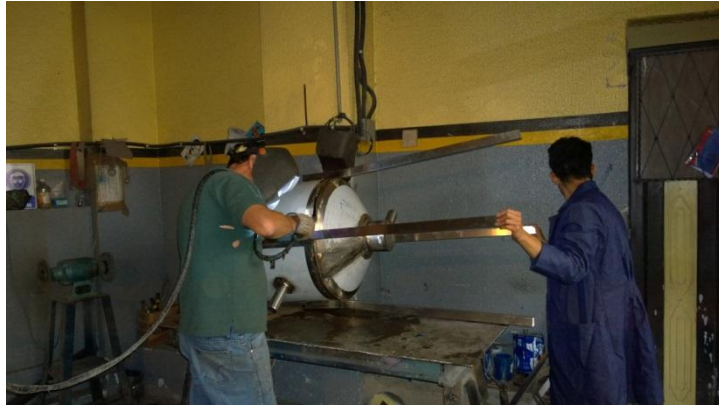
Fotografía 7. Soldado de los materiales.
