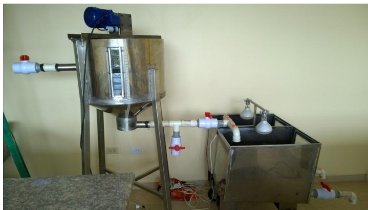
Fotografía 13. Sistema de tratamiento de lodos residuales implementado.
