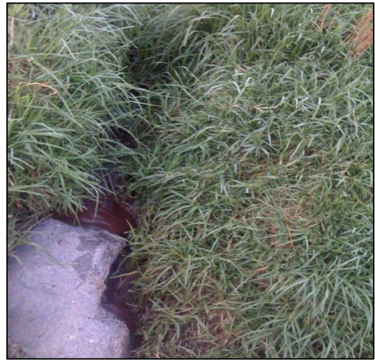
F5: Punto de descarga N°2
