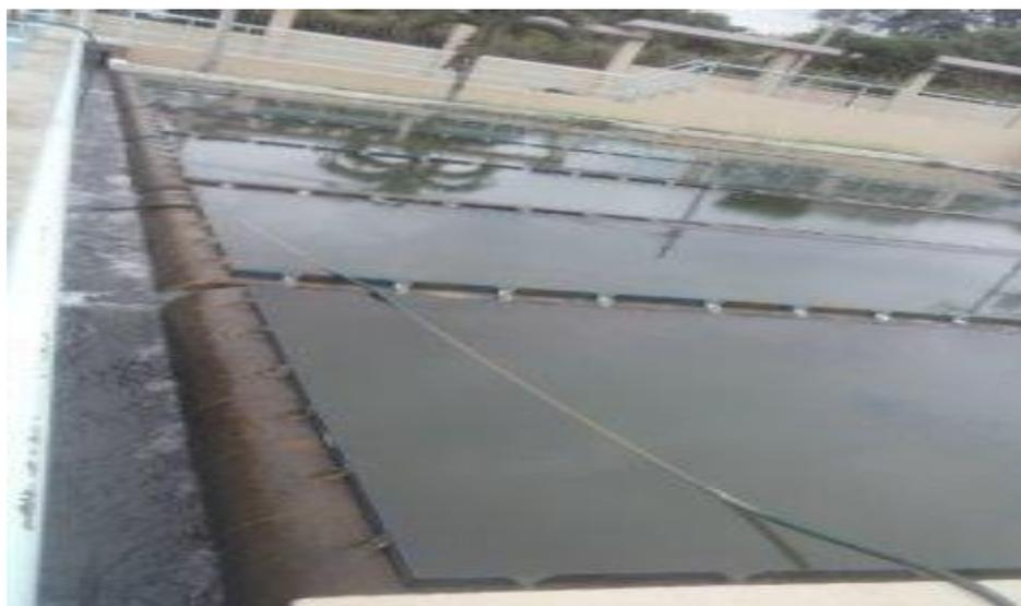
**Figura 8-2:** Sedimentadores en la Planta de Tratamiento de Agua Potable de Santo Domingo de los Tsachilas
