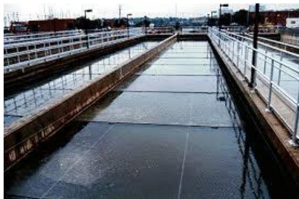
**Figura 20-1:** Sedimentador rectangular
