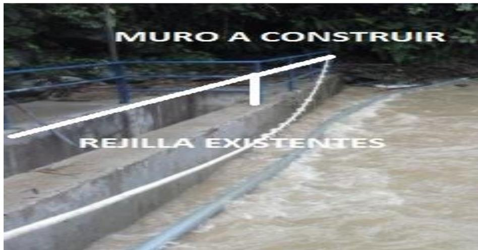
**Figura 2-3:** Captación, prolongación del muro existente
