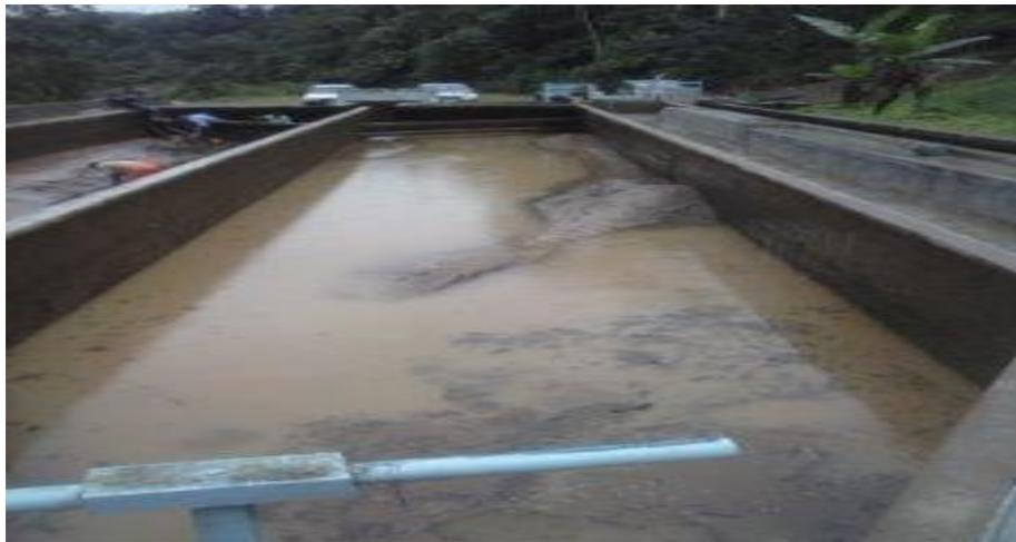
**Figura 4-2:** Desarenador de la Planta de Tratamiento de Agua Potable de la ciudad de Santo Domingo de los Tsachilas
