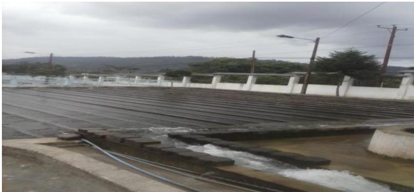
**Figura 7-2:** Floculadores en la Planta de Tratamiento de Agua Potable de Santo Domingo de los Tsachilas
