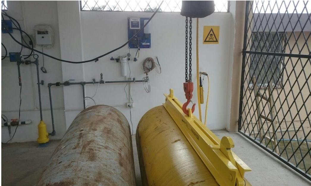
**Figura 13-2:** Desinfección en la Planta de Tratamiento de Agua Potable de Santo Domingo de los Tsachilas
