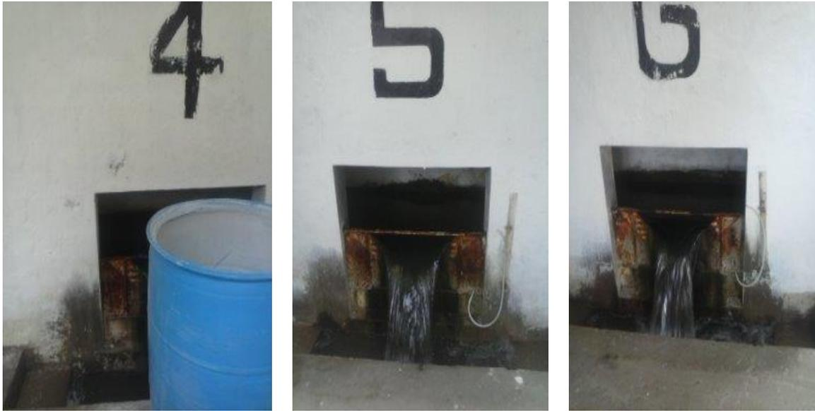
**Figura 11-2:** Vertederos de salida de filtros en la Planta de Tratamiento de Agua Potable de Santo Domingo de los Tsachilas
