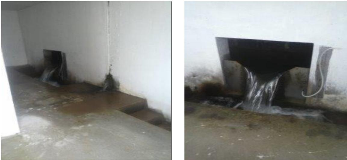
**Figura 12-2:** Vertederos de salida de filtros en la Planta de Tratamiento de Agua Potable de Santo Domingo de los Tsachilas
