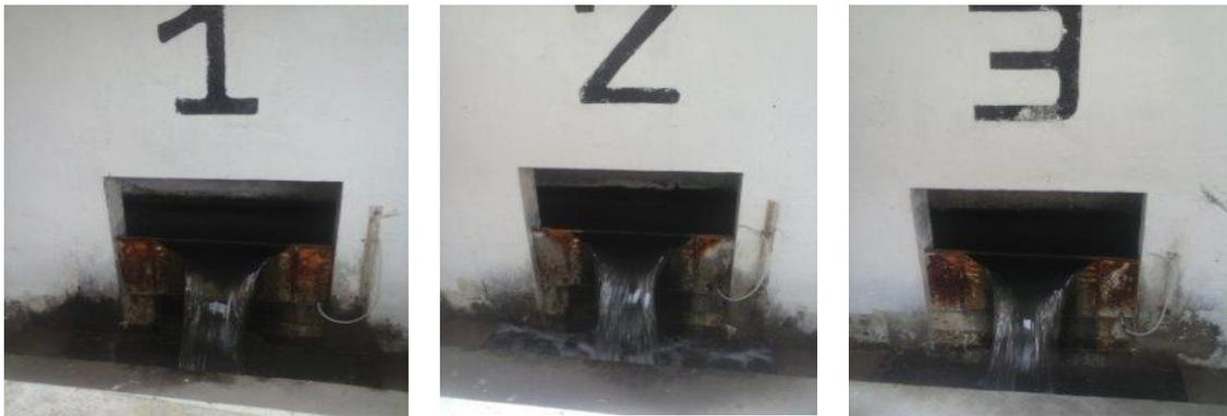
**Figura 10-2:** Vertederos de salida de filtros en la Planta de Tratamiento de Agua Potable de Santo Domingo de los Tsachilas
