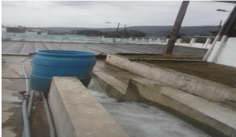
**Figura 5-2:** Aireador de cascada de la Planta de Tratamiento de Agua Potable de la ciudad de Santo Domingo de los Tsachilas
