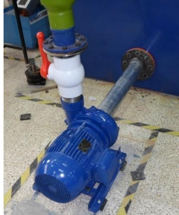
Figura 70. Instalación completa de la bomba
