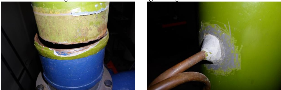
Figura 88. Corrección de fugas de agua detectadas
