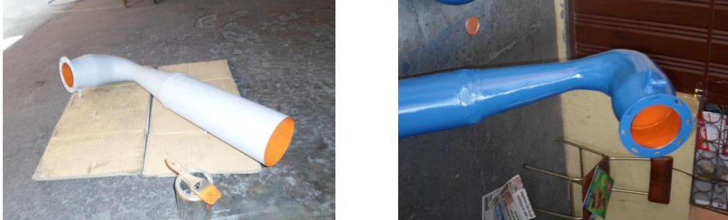
Figura 49. Mantenimiento preventivo aplicado al tubo de aspiración
