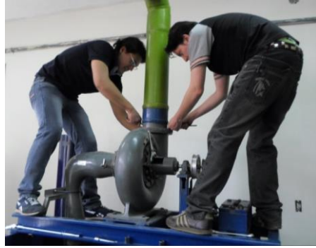
Figura 27. Desmontaje de la turbina
