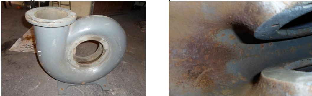
Figura 33. Mantenimiento correctivo aplicado a la carcasa de la turbina
