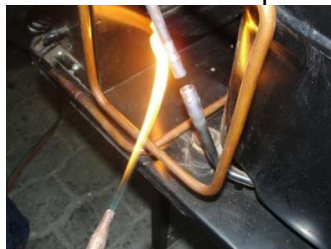
Figura 63. Soldadura de tubería de aspiración del refrigerante
