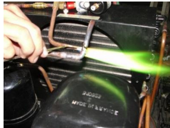
Figura 68. Soldadura de tubería de cobre
