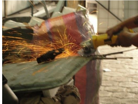
Figura 80. Esmerilado de escoria tras soldadura
