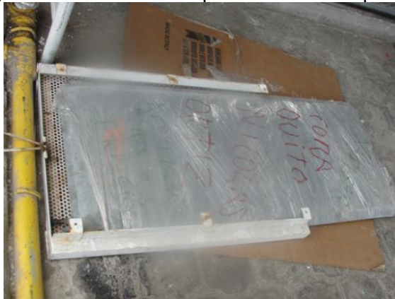
Figura 49. Armado de la placa metálica importada
