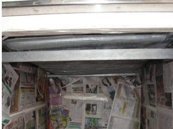
Figura 104. Caja térmica pintada tras montaje de placa eutéctica
