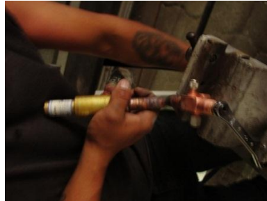
Figura 94. Conexión de válvula KVL al sistema
