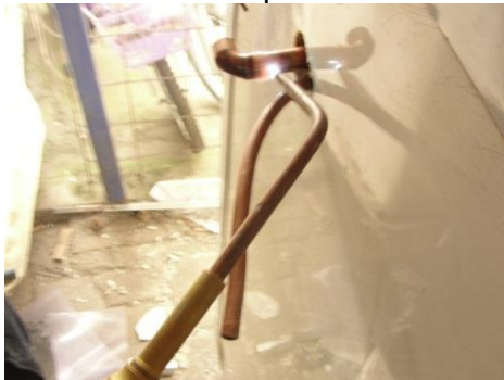
Figura 98. Suelda de codo de cobre para continuar secuencia de tubería
