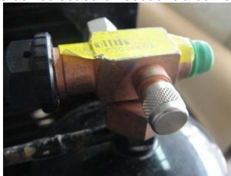
Figura 57. Válvula Rotalock colocada en secuencia con el acumulador de líquido
