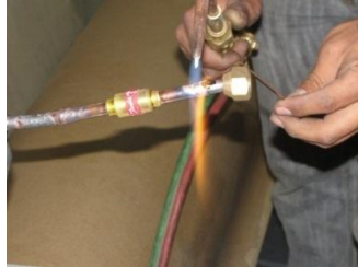
Figura 67. Soldadura de la válvula unidireccional al sistema
