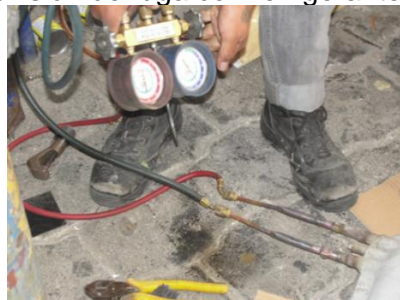
Figura 55. Revisión de fuga con refrigerante a alta presión
