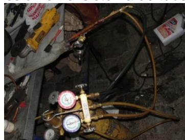
Figura 93. Prueba de presión en el sistema de tubería de la placa eutéctica
