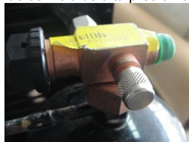
Figura 36. Válvula de servicio de alta presión 3/8", marca Danfoss
