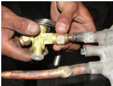
Figura 89. Conexión roscada de válvula de expansión
