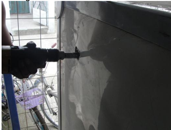
Figura 48. Perforación del sistema
