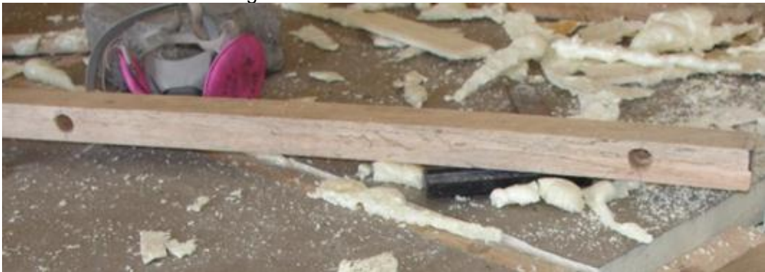
Figura 46. Armado del aislamiento
