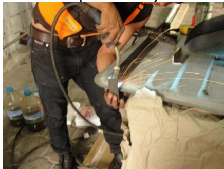
Figura 81. Soldadura de soporte de sujeción de la placa eutéctica
