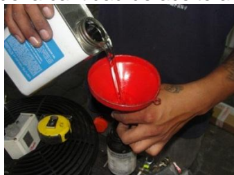
Figura 69. Medida de la cantidad de aceite a introducir al sistema
