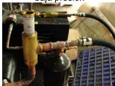
Figura 101. Cierre del circuito frigorífico con válvula KVL con acoples a manguera de baja presión
