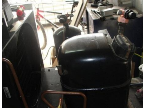
Figura 58. Montaje sobre base de compresor, condensador y tubería
