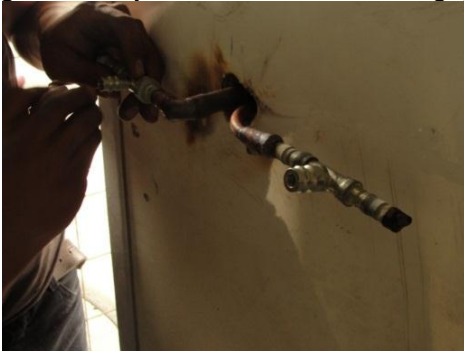
Figura 99. Ajuste de válvulas con agujas
