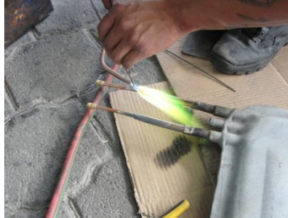
Figura 53. Soldadura de las válvulas de servicio con la tubería de la entrada y salida de la placa
