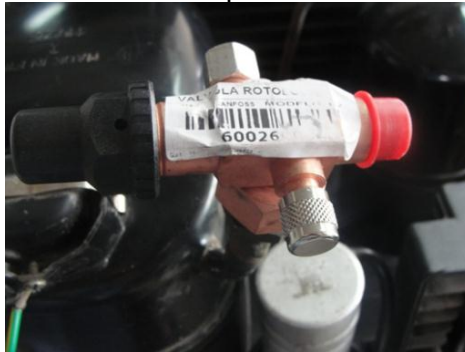
Figura 56. Válvula Rotalock colocado para aspiración de refrigerante hacia el compresor
