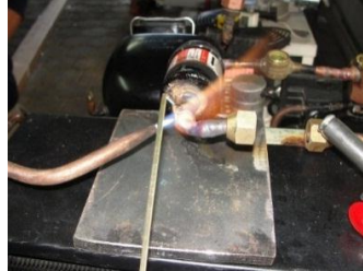
Figura 73. Tubería con tuerca de bronce soldada a boca de salida de filtro secador
