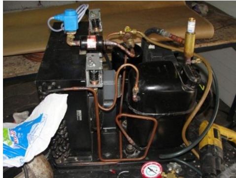
Figura 105. Conexión de la bobina solenoide
