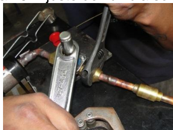
Figura 75. Ajuste de válvula solenoide
