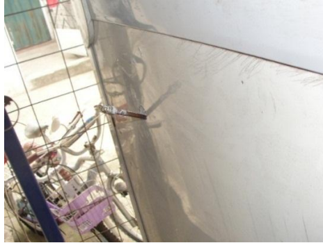
Figura 97. Tubería atravesando la placa eutéctica
