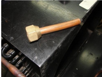
Figura 65. Tuerca y tubería de cobre
