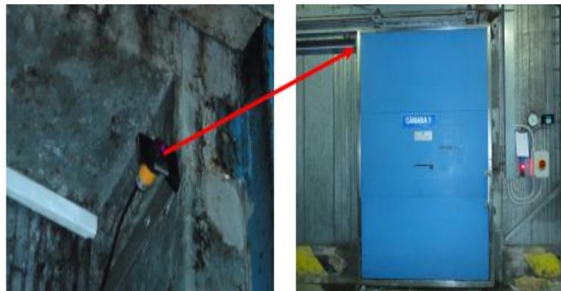
Figura 52. Instalación del sensor fotoeléctrico
