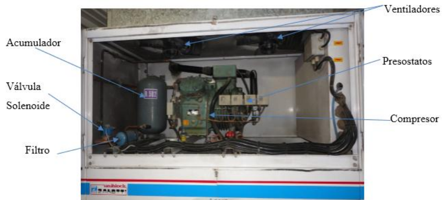
Figura 25. Componentes de una cámara de refrigeración
