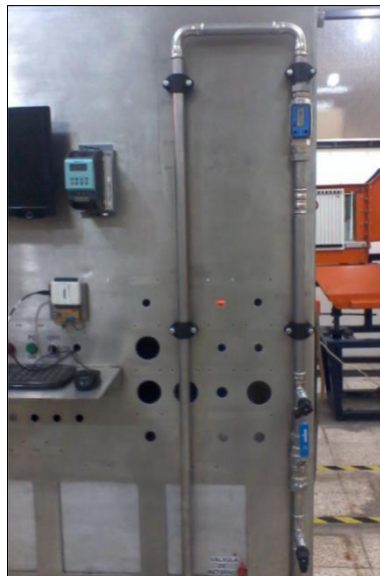
Figura 33. Instalación sistema hidráulico
