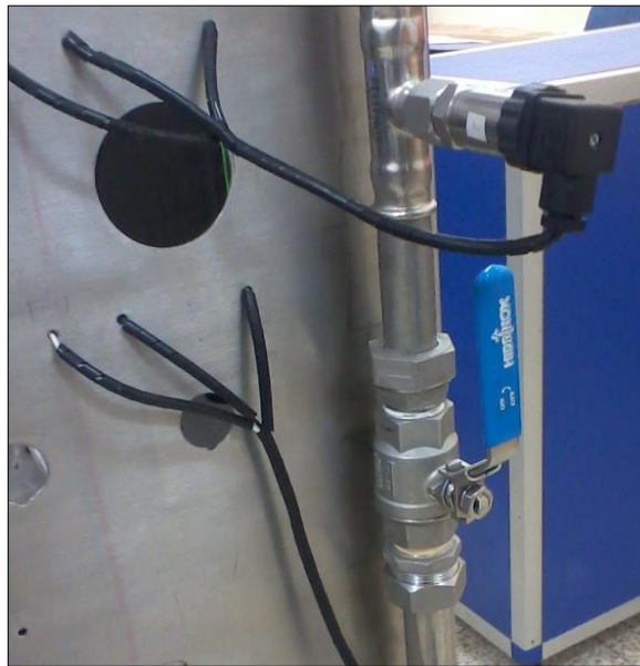
Figura 35. Instalación sensores de presión
