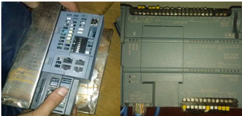
Figura 41. Montaje y conexión del PLC
