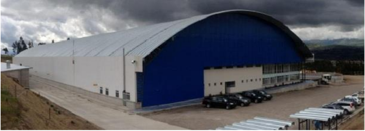
Figura 2-3: Localización de la Empresa CIAUTO instalaciones Fuente: CIAUTO
