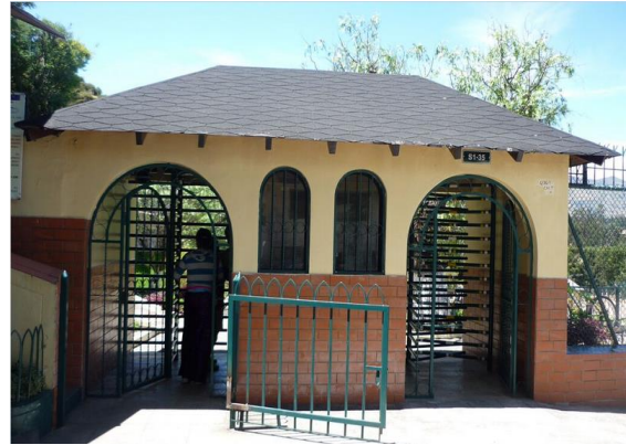
Fotografía N°3: Entrada principal del Balneario Fuente: NARANJO, C. 2015
