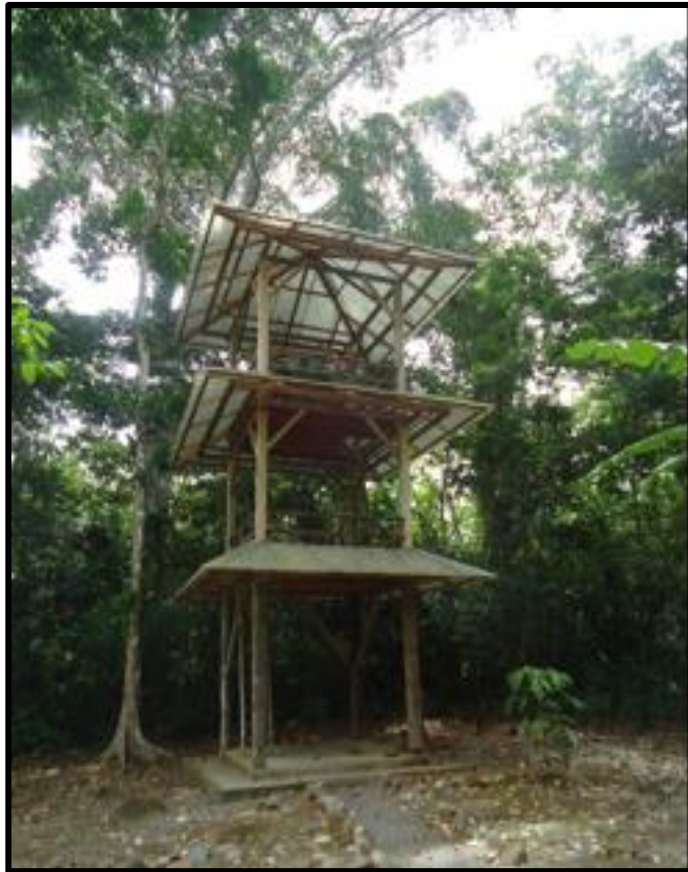
Foto 23. Torre de observación
