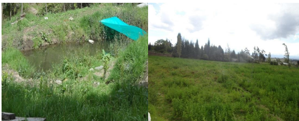
Foto No.10. Tanque reservorio
