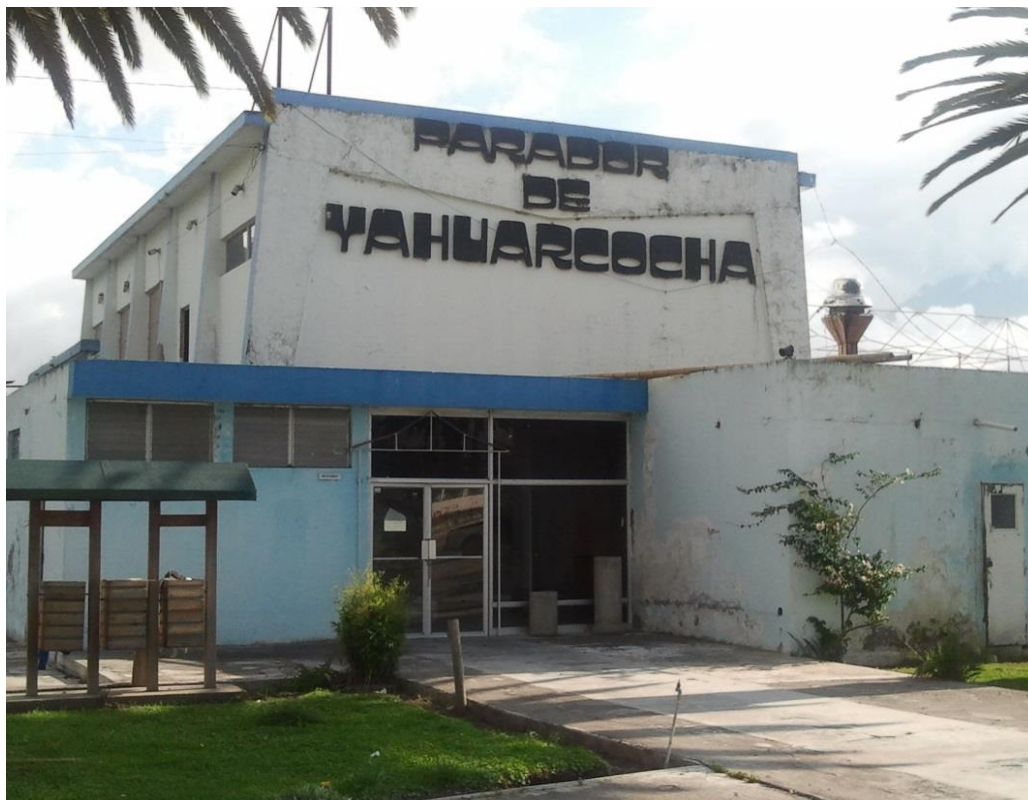
Foto 5. Fachada frontal de la edificación
