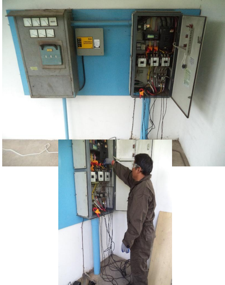
Figura 23. Conexión del equipo al tablero del pozo Uno
