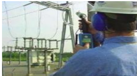
Figura 8. Inspección de instalaciones eléctricas utilizando la técnica de ultrasonido.
