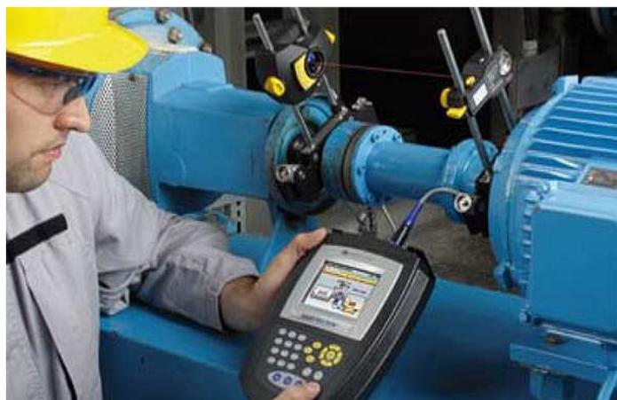
En las operaciones de mantenimiento, el mantenimiento predictivo es el que está basado en la determinación del estado de la máquina en operación. El concepto se basa en que las máquinas darán un tipo de aviso antes de que fallen y este mantenimiento trata de percibir los síntomas para tomar acciones.
