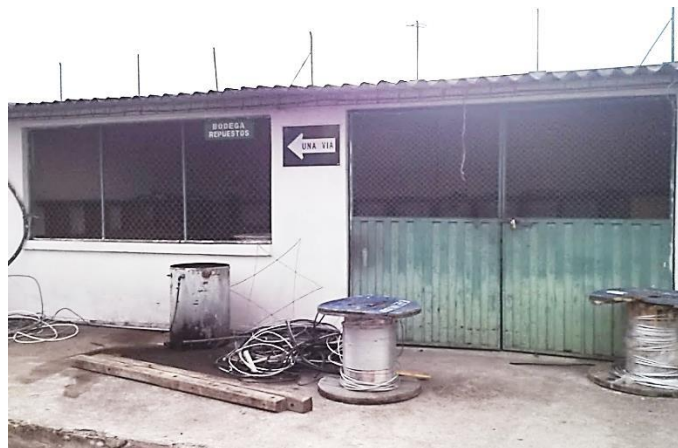
Figura 34. Señalización inadecuada en la bodega de repuestos
