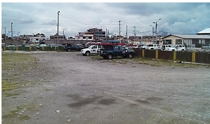
Figura 40. No existe señalización en el parqueadero
