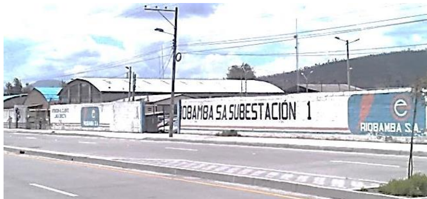
Figura 11. Subestación uno frontal
