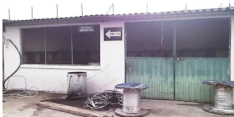
Figura 15. Bodega de repuestos del taller automotriz de la E.E.R.S.A.
