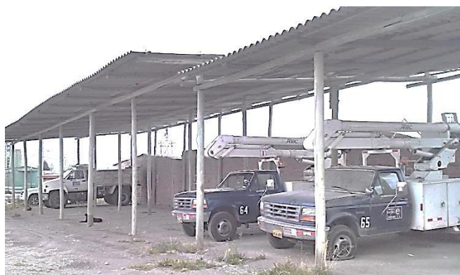
Figura 16. Parqueadero del taller automotriz de la E.E.R.S.A.
