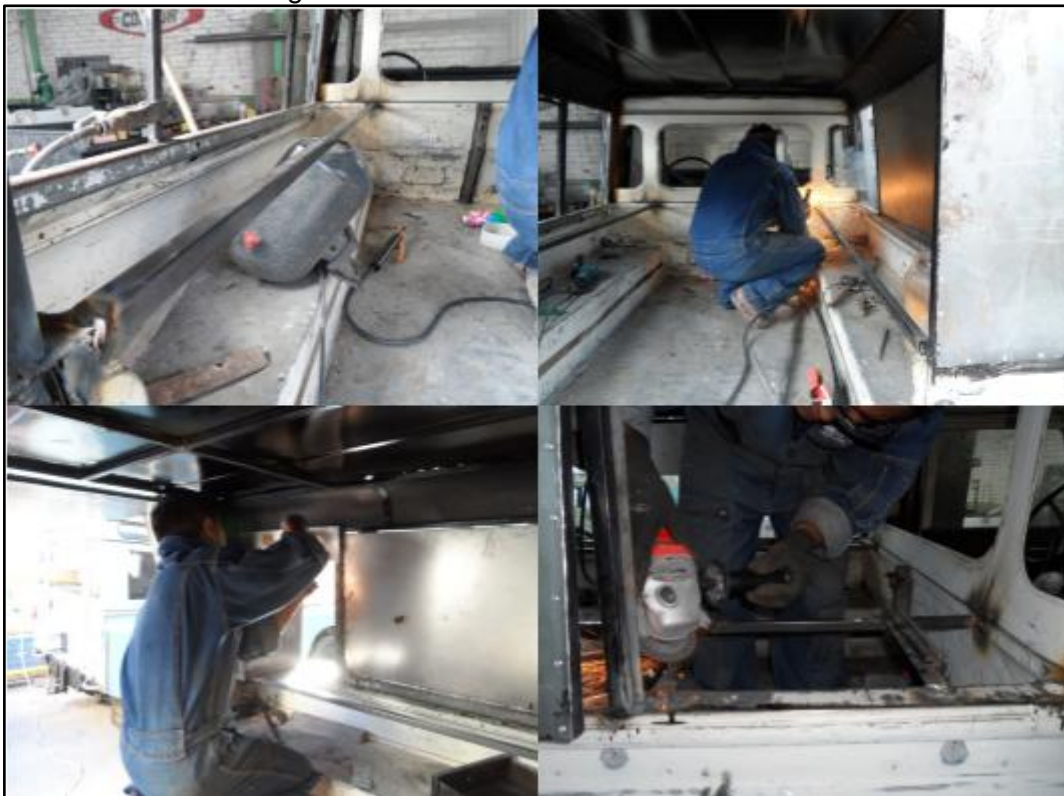
Figura 74. Construcción del marco interno
