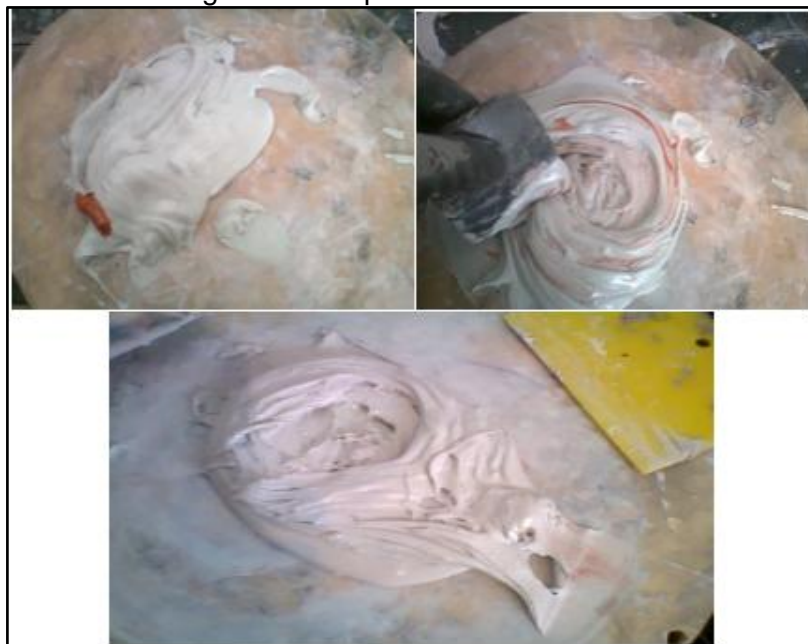
Figura 44. Preparación de la masilla
