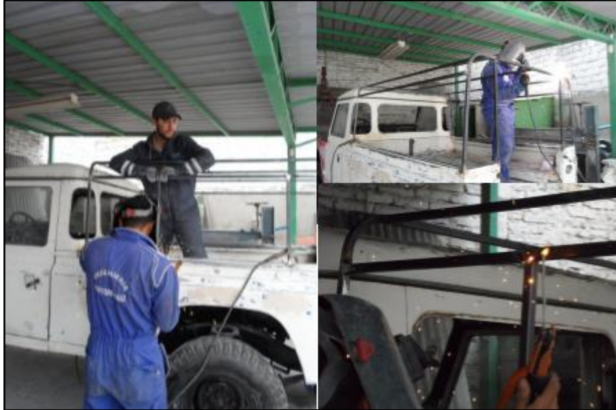
Figura 67. Soldado de la estructura
