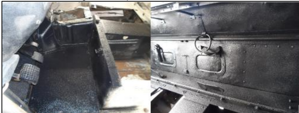
Figura 26. Superficie oxidada terminada
