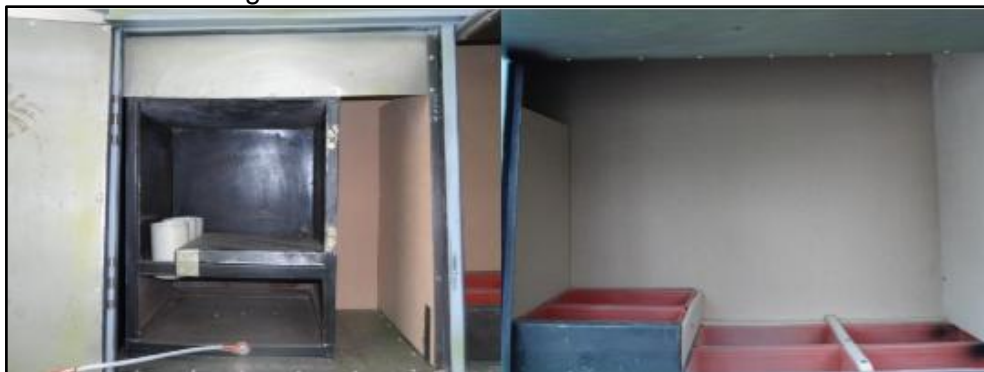
Figura 77. Recubrimiento interior con MDF
