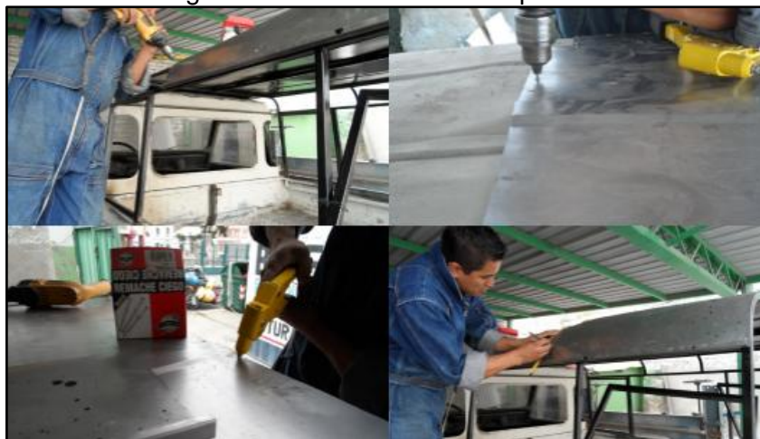
Figura 71. Remachado de los paneles
