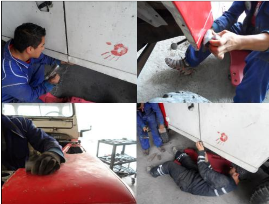
Figura 20. Reparación de abolladuras
