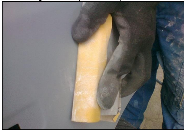
Figura 89. Lijado de imprimación
