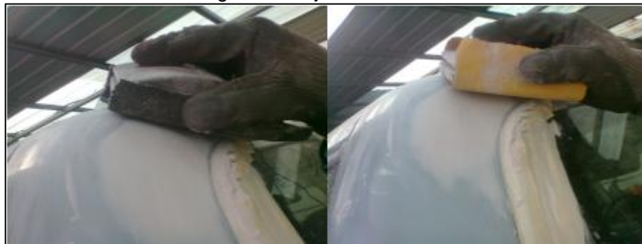
Figura 47. Lijado de masilla
