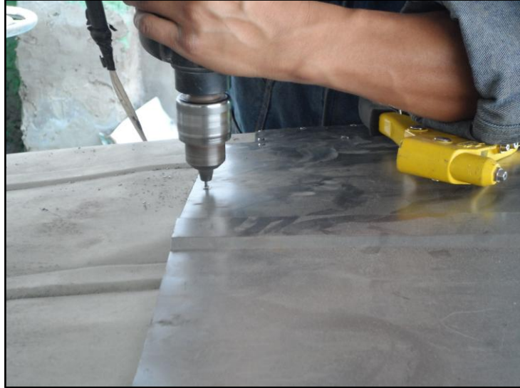
Figura 25. Reemplazo de la zona oxidada
