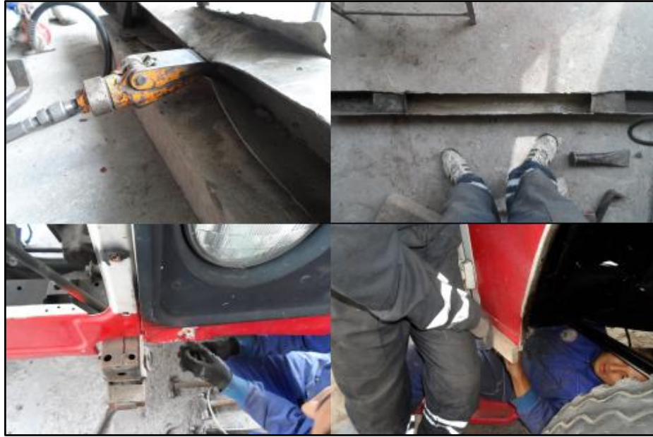
Figura 37. Enderezado de daños
