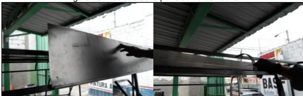
Figura 70. Doblado de la parte curva del techo.
