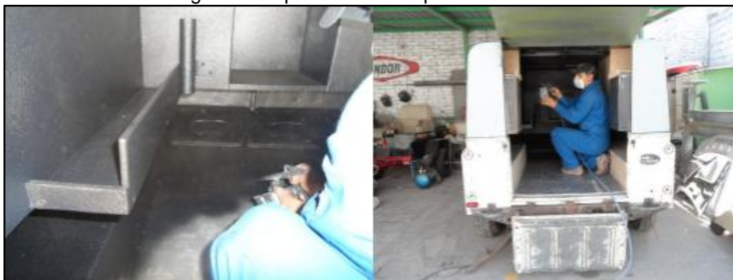
Figura 81. Aplicación del impermeabilizante
