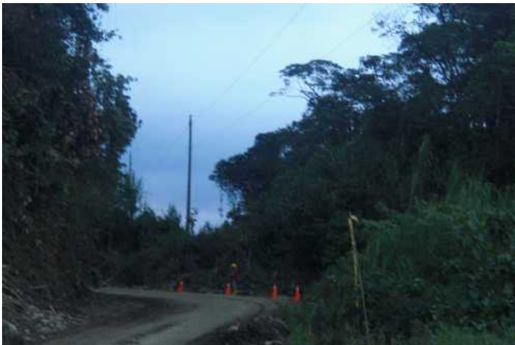
Figura 109. Cableado eléctrico vía 9 de Octubre - Zuñac
