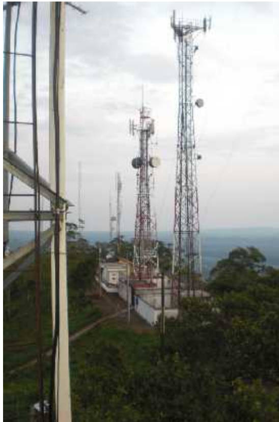
Figura 108. Infraestructura en el Kilamo
