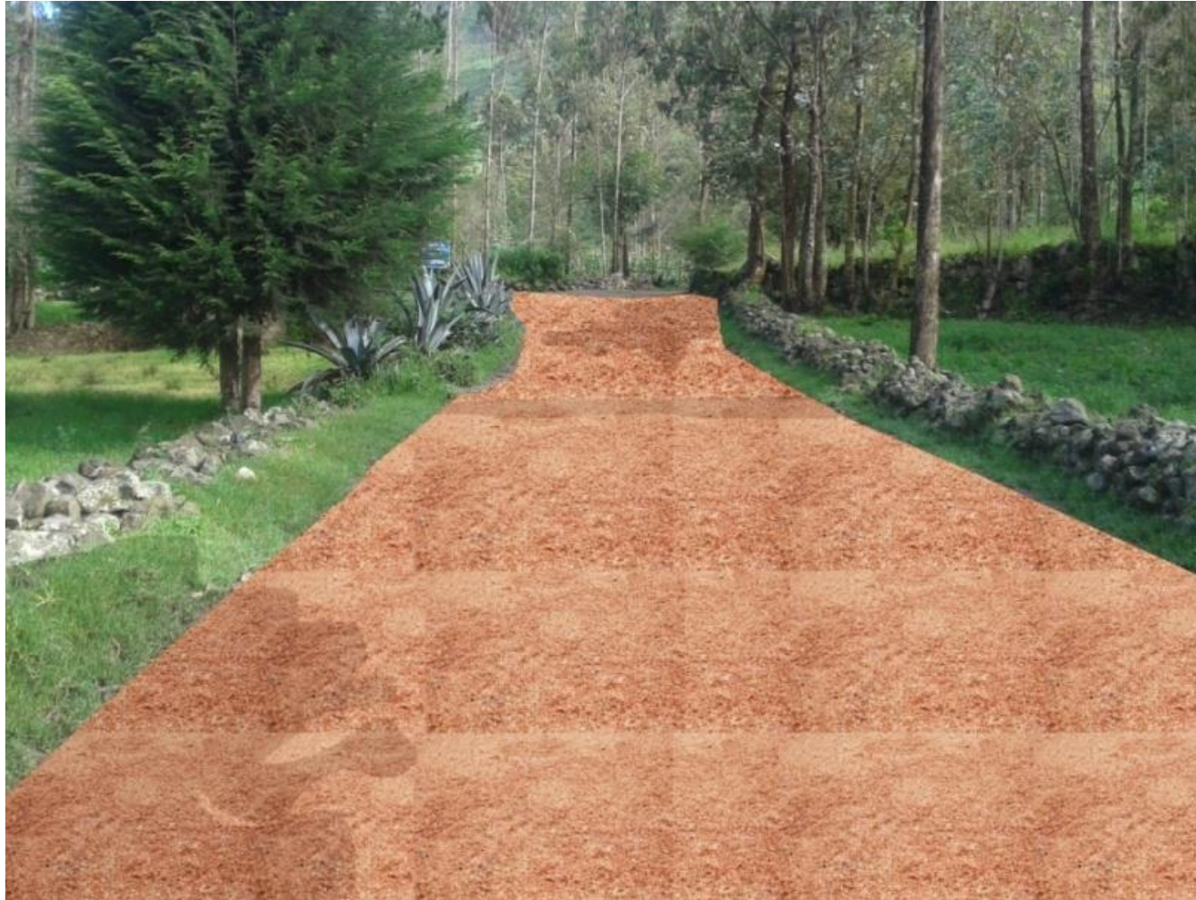
Figura 19. Camino reconstruido en carretera
