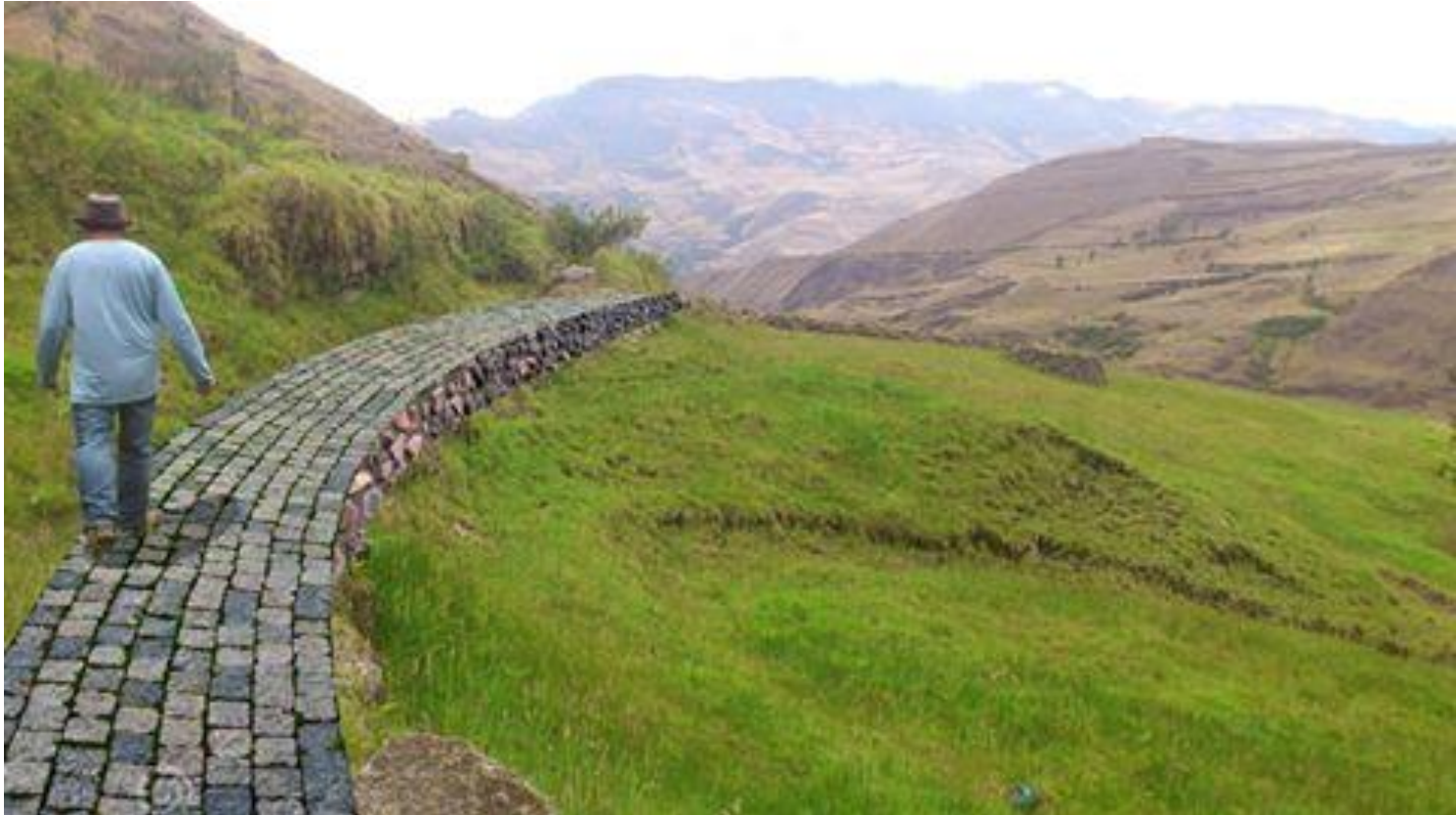
Figura 16. Camino reconstruido sin muros laterales
