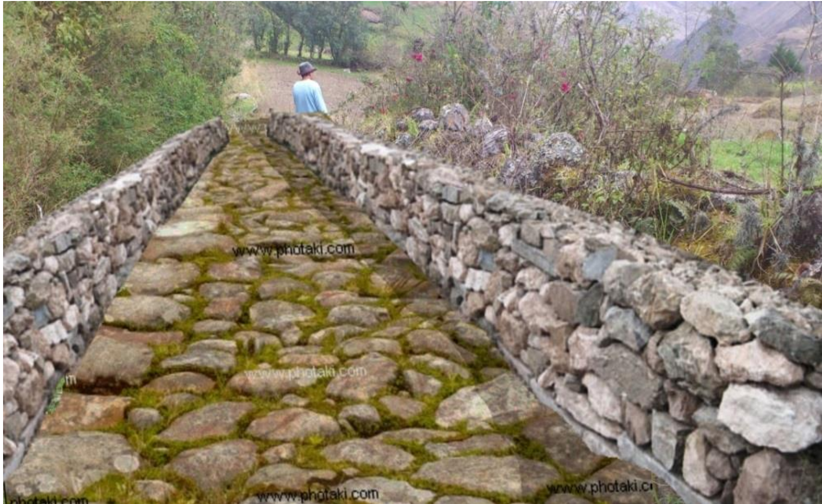
Figura 17: camino reconstruido con muros laterales
