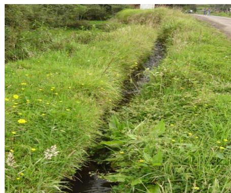
Figura 21. Canal de tierra S. de R San Antonio derivación el Vergel
