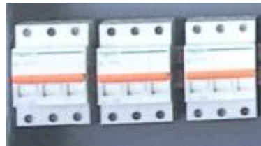
Figura III-15. Breakers Trifásicos
