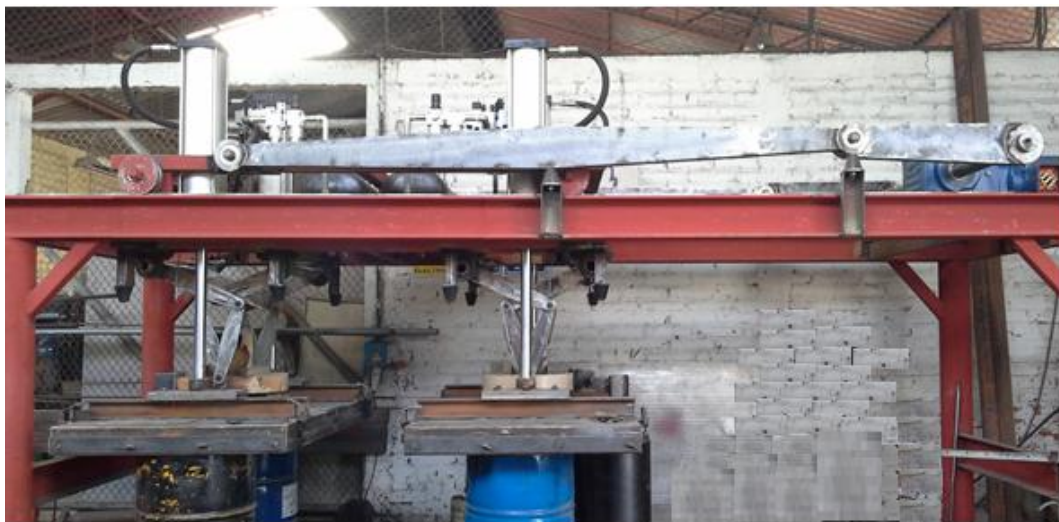
Figura III-23. Máquina de desmoldeo Fuente.- Los Autores
