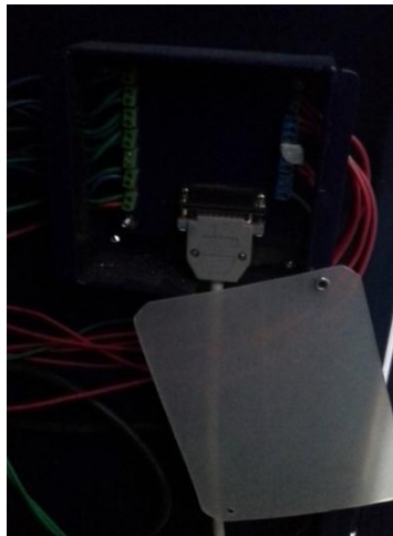
Figura III-72. Cableado Tarjeta Electrónica 1 Fuente.- Los Autores
