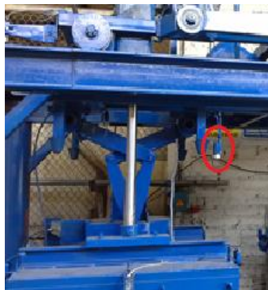
Figura III-82. Final de Carrera Superior Molde Fuente.- Los Autores
