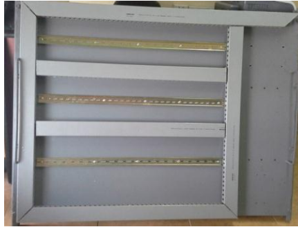
Figura III-62. Estructura del Tablero Real Fuente.- Los Autores
