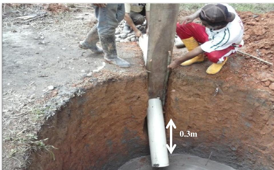
**FOTOGRAFÍA 6.** Túnel de salida del biol y acceso al mantenimiento interno.
