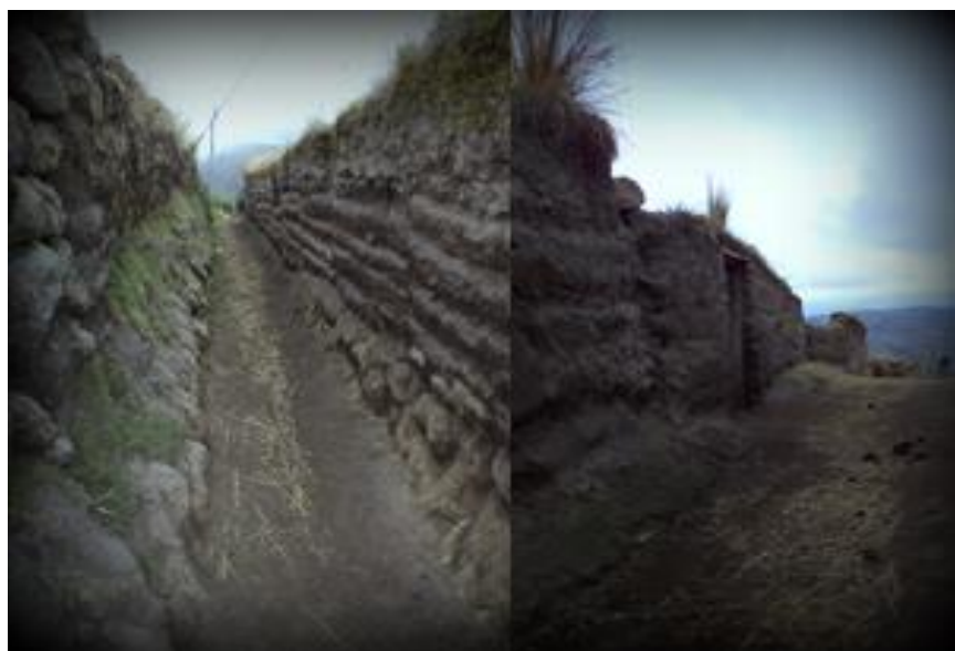
Fotografía 12. Tapiales contruidos como sistema de protección
