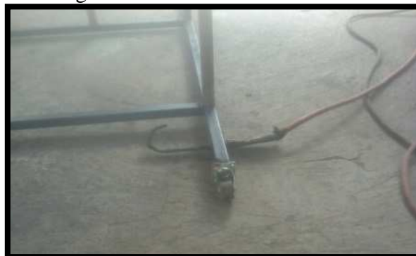
Figura 68. Soldadura de las ruedas
