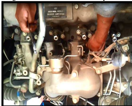
Figura 97. Ubicación de los inyectores
