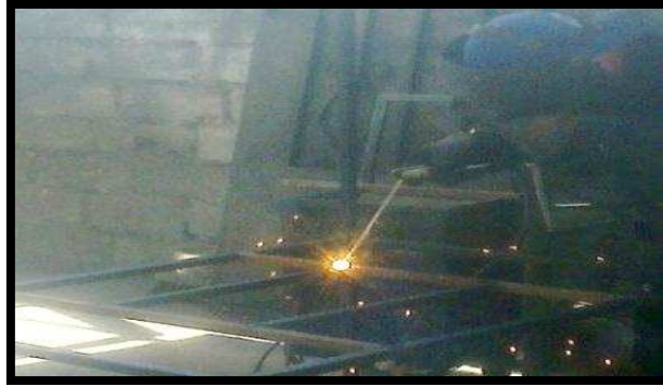
Figura 66. Soldadura total de la estructura
