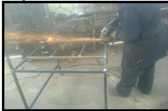
Figura 67. Esmerilada de la estructura
