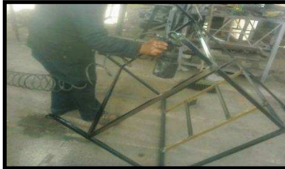
Figura 70. Proceso de pintura
