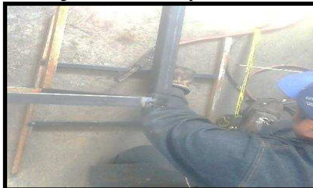
Figura 65. Soldadura parte interna
