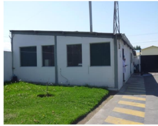
FOTOGRAFÍA NO. 2 INSTALACIONES EXTERNA DEL LABORATORIO DE ALIMENTOS MOCEPROSA S.A
