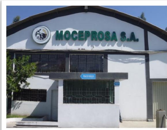
FOTOGRAFÍA NO. 1 INSTALACIONES EXTERNA DE LA EMPRESA MOCEPROSA S.A
