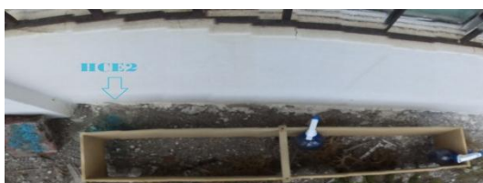
FOTOGRAFÍA No.11 UBICACIÓN HCE2
