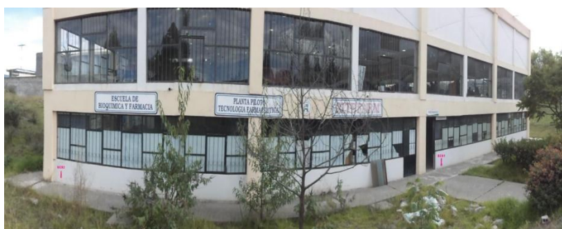
FOTOGRAFÍA No. 20 BIBLIOTECA CARA SUR
