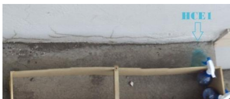
FOTOGRAFÍA No.10 UBICACIÓN HCE1
