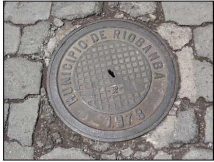
Fotografía del Alcantarillado actual de la zona.
