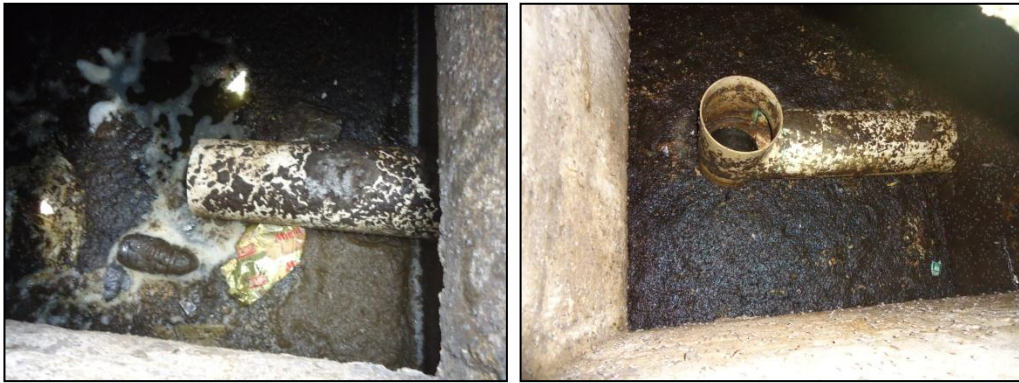
(d) Decantador (proceso de digestión anaerobia)
