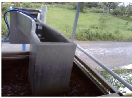
Mezcla rápida (canaleta parshall)
