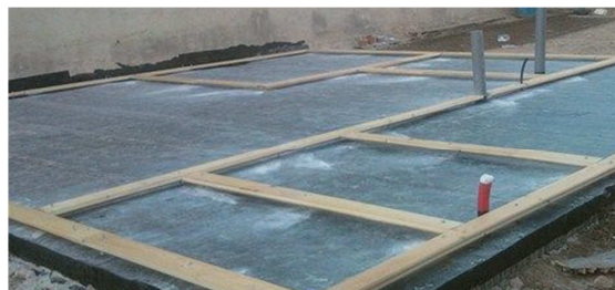
Figura 19. Función secundaria de soporte estructural de una instalación
