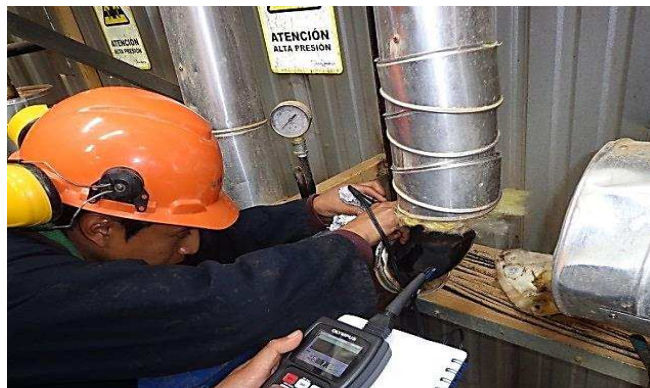
Figura 66. Inspección de puntos seleccionados
