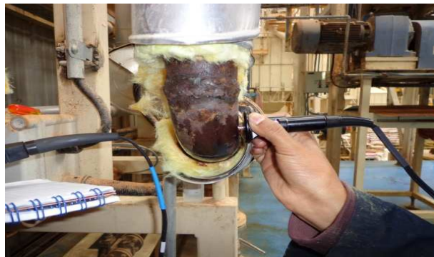
Figura 59. Puntos de referencia para la inspección
