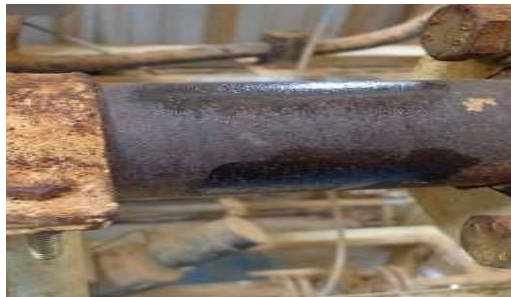
Figura 62. Señalización de puntos críticos
