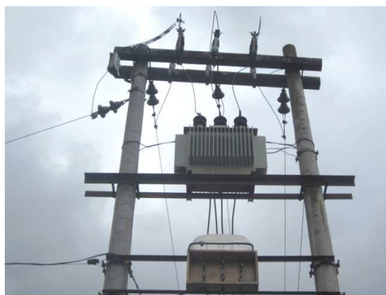
Figura 7. Transformador trifásico
