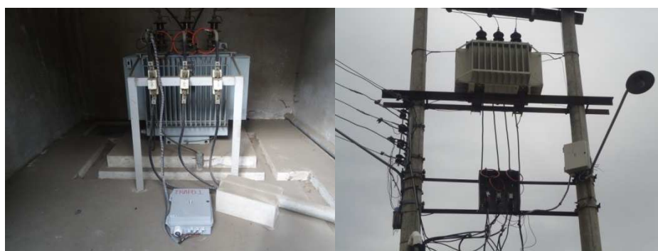
Figura 22. Instalación del analizador de redes en los transformadores
