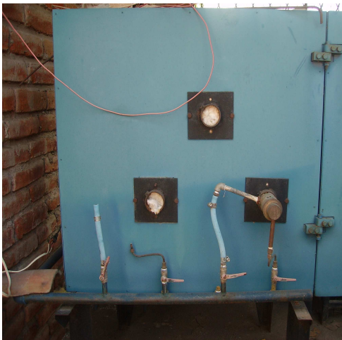
Figura 16 Quemadores del lado izquierdo del horno.
