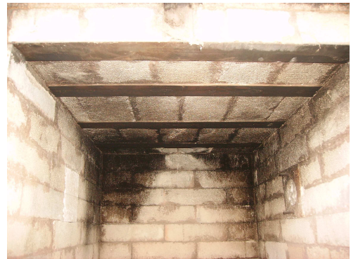
Figura 12 Bóveda del horno.
