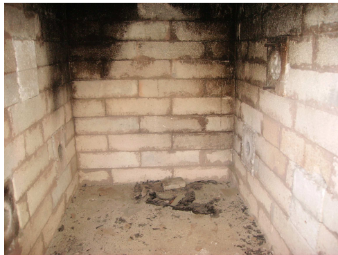
Figura 11 Interior del horno
