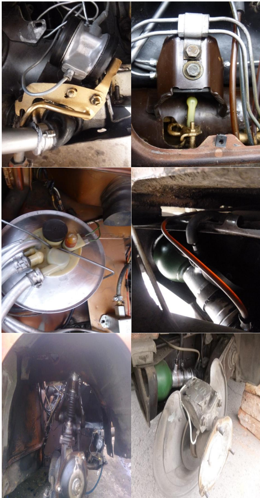
Figura 42. Ensamble del sistema hidroneumático
