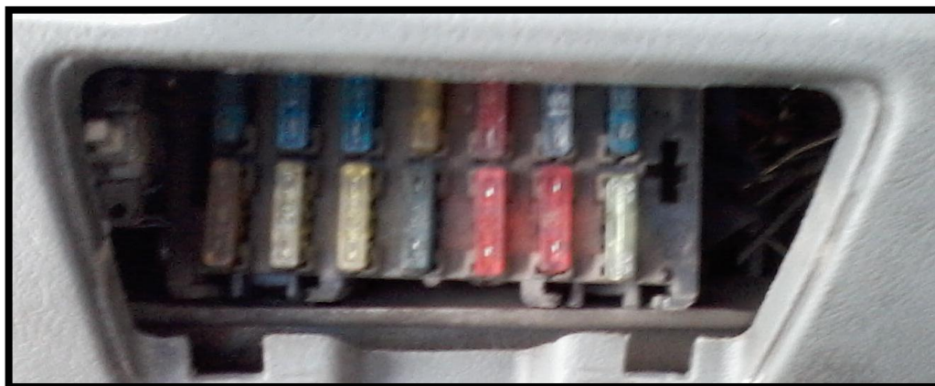
Figura 54. Sustitución de fusibles
