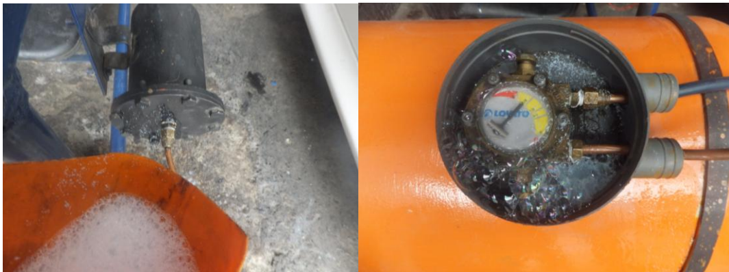
Figura 81. Verificación de conexiones
