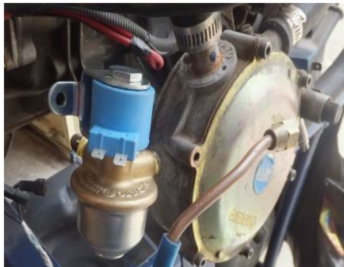
Figura 67. Instalación de la electroválvula de GLP
