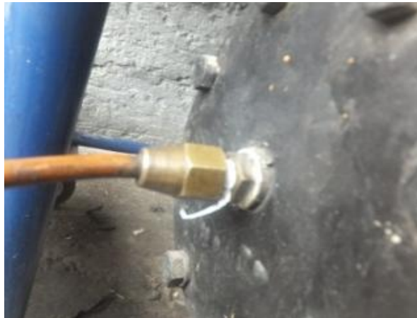
Figura 63. Instalación de las tuberías
