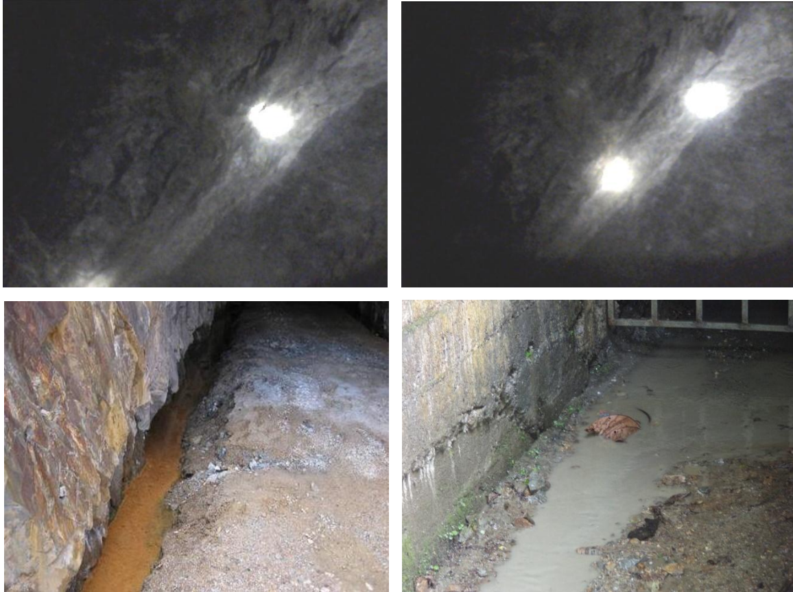
Foto 2.1-4 Salida del efluente por el interior de la mina
