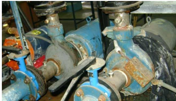
Figura 16. Bombas centrífugas de presión constante
