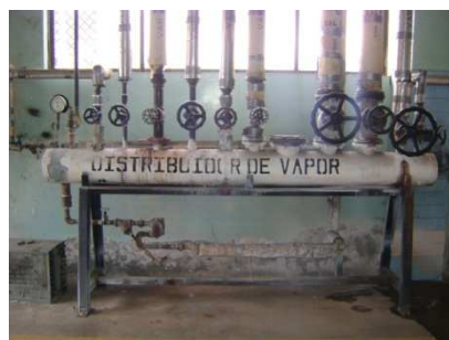
Figura23. Distribuidor de vapor
