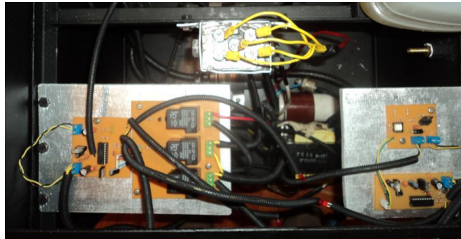
Figura 67. Colocación sistema eléctrico y electrónico.
