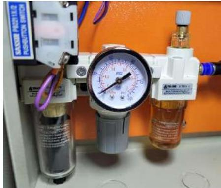
Revise el regulador de aire y en caso de que esté presente agua en el depósito de filtrado depúrelo girando la válvula en la parte inferior del depósito.
