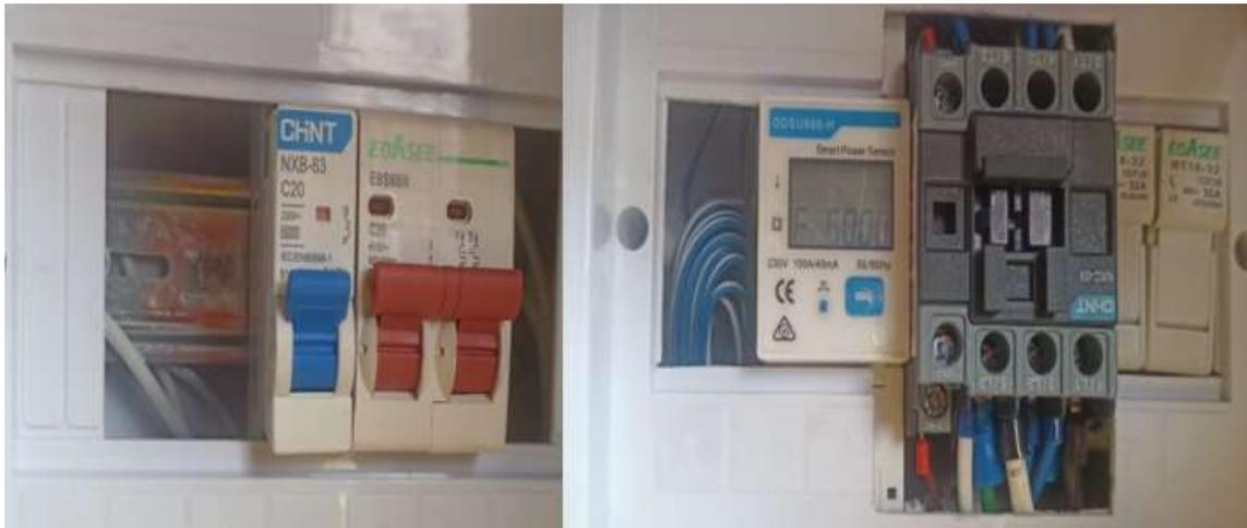
**Ilustración 3-25:** Protecciones del sistema fotovoltaico
