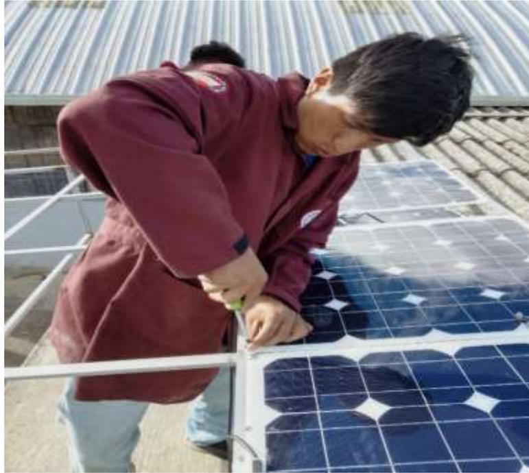
**Ilustración 3-22:** Colocación de los paneles solar a la estructura metálica
