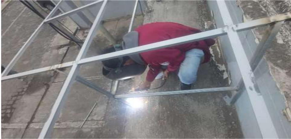
**Ilustración 3-21:** Construcción de la estructura de soporte de acero
