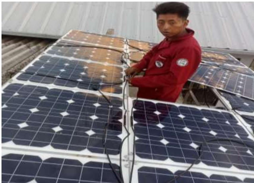
**Ilustración 3-23:** Conexión en serie de los paneles solares
