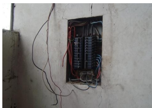
Figura 2.16: Caja de breakers del taller del máquinas herramienta
