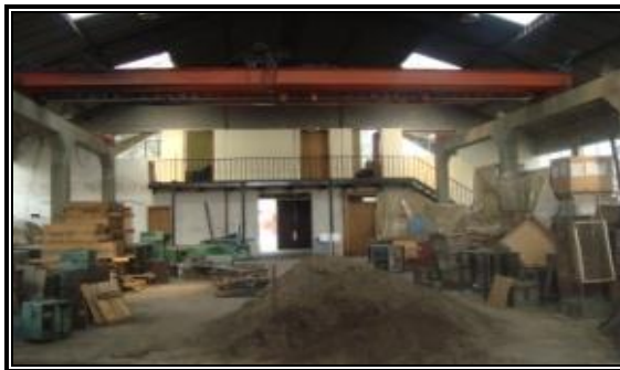
Figura 2.9: Ausencia de extintores.
