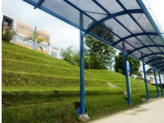
Ilustración 2- 7: Cubierta peatonal en vidrio templado
