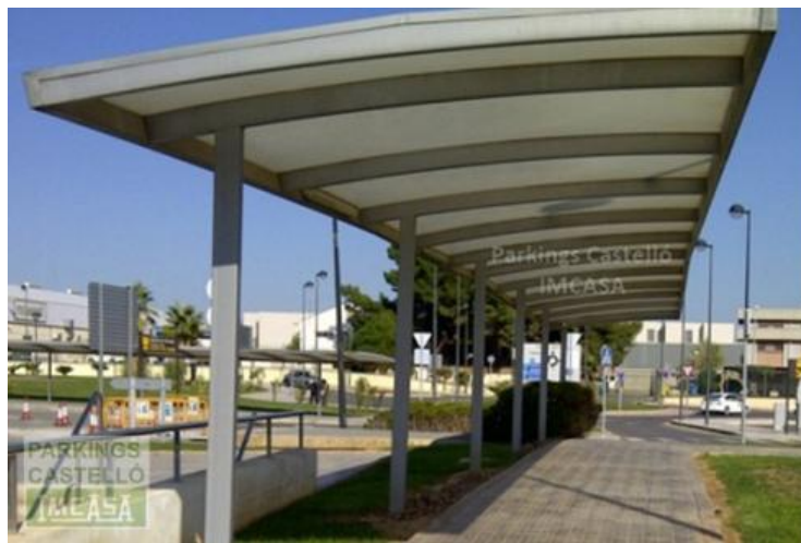
Ilustración 2- 6: Cubierta Peatonal de Policarbonato
