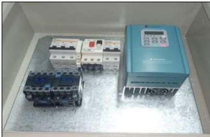
**Ilustración 3-63:** Colocación de los elementos de control de actuadores.
