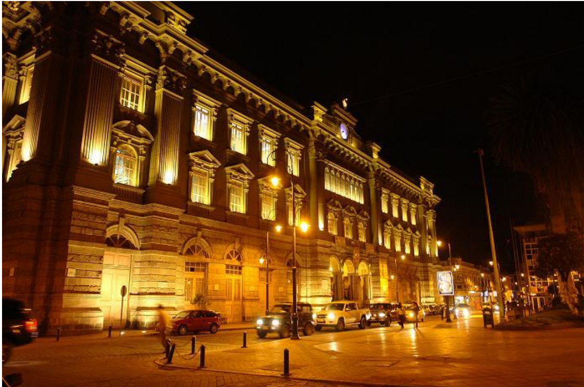
Foto N° 26: Edificio del Colegio Pedro Vicente Maldonado
