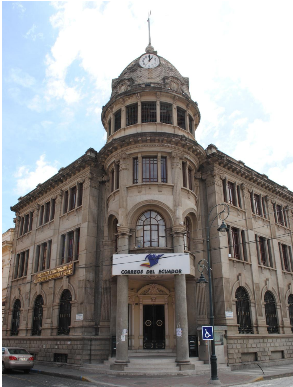
Foto N°7: Edificio del Correo
