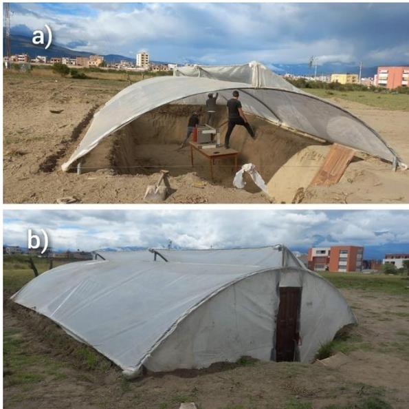
**Ilustración 3-9:** a) Estructura; b) Invernadero terminado
