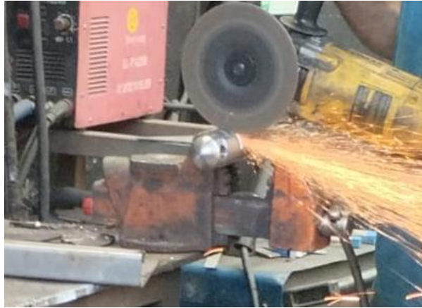
Ilustración 3-35: Proceso de corte del eje sobrante del molde.
